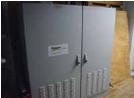
Energieoptimierungsmaschine (Anlage zur Verbrauchssenkung durch Spannungsreduzierung)
