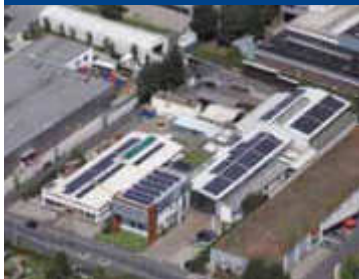
Gelände der Firma Huhle mit Photovoltaik-Anlage
