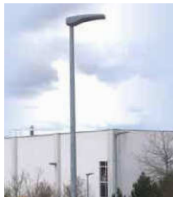
Die erneuerte Parkplatz-Außenbeleuchtung
