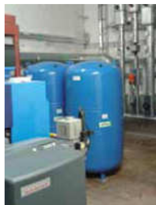
Die 2015 installierte neue Heizungsanlage mit Energieeffizienzpumpen
