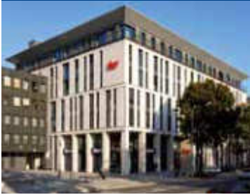
Die SV SparkassenVersicherung in der Wiesbadener Bahnhofstraße
