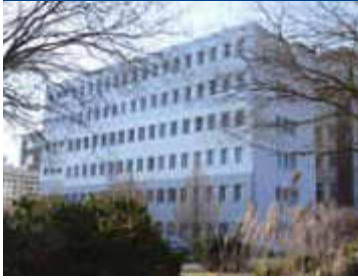
Energetisch saniertes Verwaltungsgebäude mit Alpolite™ Fassadenverkleidung
