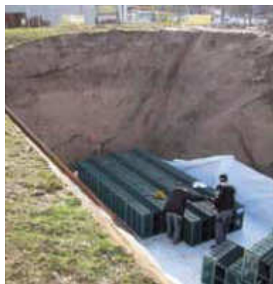
Baustelle Rigole zur Regenwasserversickerung
