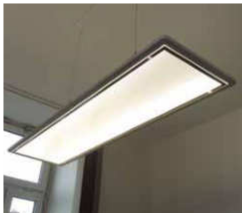
LED-Beleuchtung in Büroräumen
