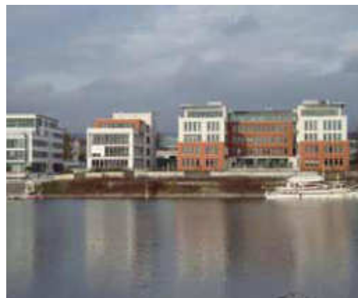
SCHUFA-Gebäude aus der Fernansicht
