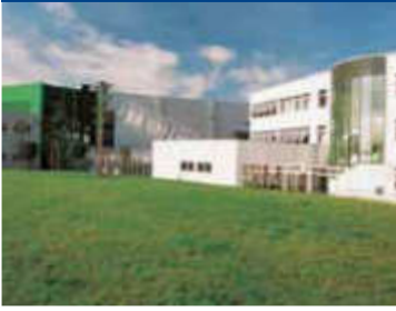
Blick auf die Verwaltung und im Hintergrund das Hochregallager von WERO
