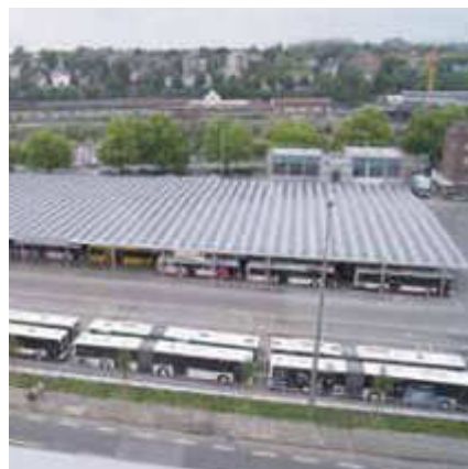
Photovoltaikanlage auf dem Busport
