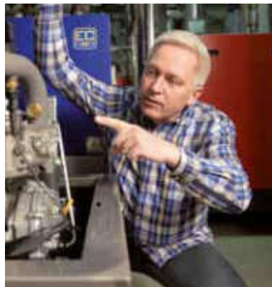
ABO Wind-Mitarbeiter Klaus Ruffert in der umgebauten und deutlich effizienteren Heizungsanlage
